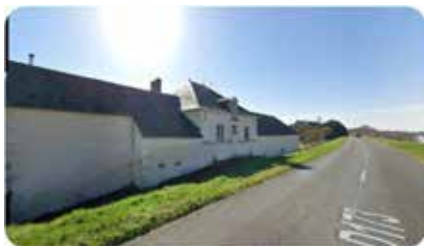
Sur le pignon de la maison Lieu dit « La Petite Maison »
